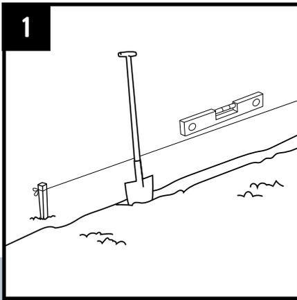
Creusez une tranchée. Veillez à ce qu'au moins la moitié de la bordure peut disparaître sous terre. Pour une bordure droite, à l'aide d'une corde et de piquets, marquez la ligne sur laquelle le Multi-Edge ECO sera placé, afin d'obtenir un résultat plus net.
